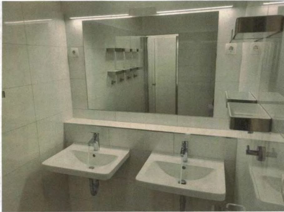
Dom ŠD3 po prenovi:
