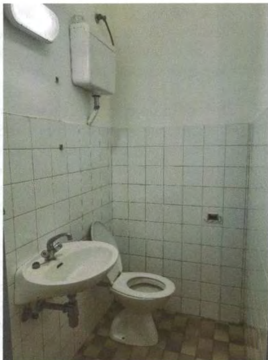
Dom ŠD3 pred prenovo:
