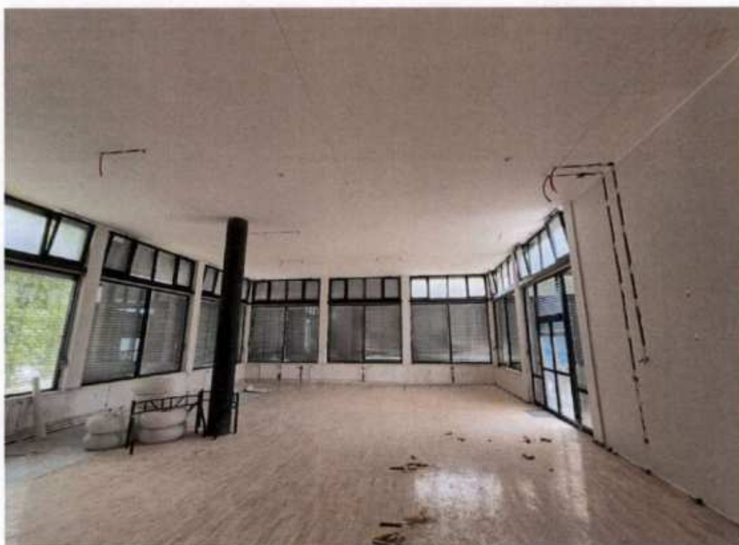
Dvorana med prenovo:
